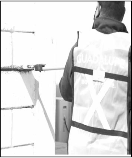
Se hicieron trabajos de pintura
